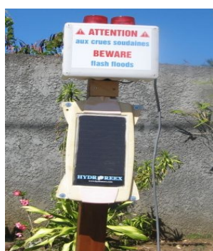
Exemple de station témoin HR-VIGI en cours de pose
