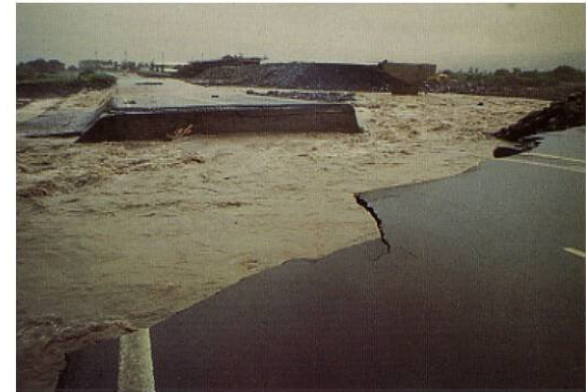
FIG. A.55 - photo 55 : Nord de l'île - Rivière des Pluies : radier emporté par la crue lors du cyclone Hyacinthe (janvier 1980).
