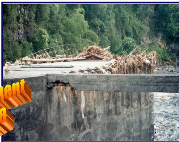
Laines de la crue de février 1998 sur la tour de la captage d'irrigation de la rivière du Mât (+ 6m)
