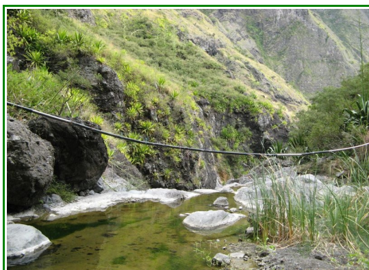
Franchissement aérien de la ravine Grand-Mère vers l'îlet des Lataniers
