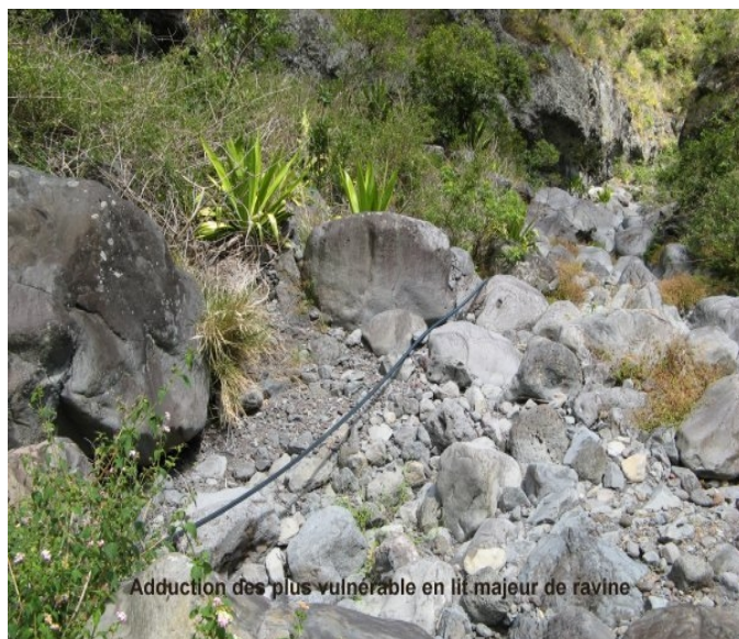
Adduction « volante » de la source Affouche vers Les Orangers
